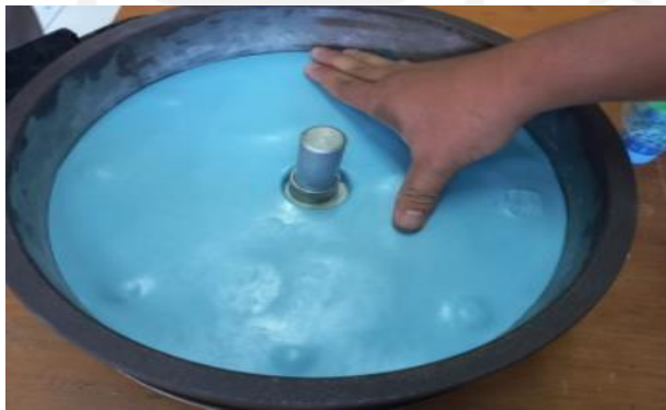
Gambar 3- 23 Pemasangan silicone rubber bagian atas
