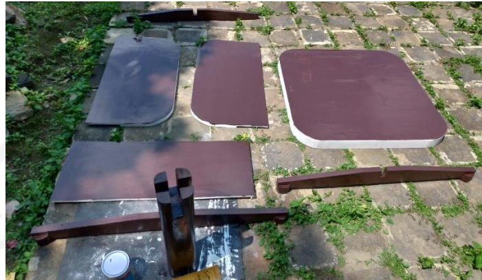
Gambar 4-25 Pengecatan komponen kayu dan multipleks
