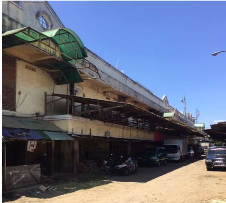
Gambar 2.4 Pasar Induk Tradisional Kroya (tampak belakang) Sumber: Dokumentasi Peneliti (2018)
