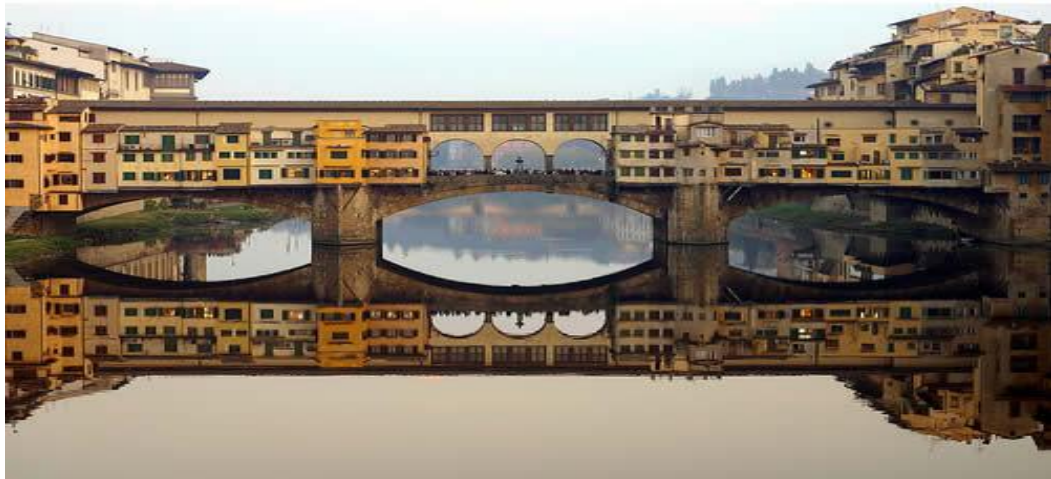
Gambar 2.1 Jembatan pelengkung bawah
