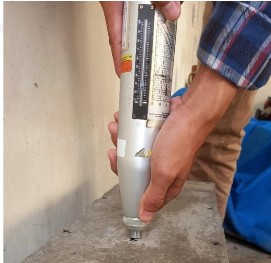
Gambar 5.5 Pengujian Hammer Test pada Balok Uji
