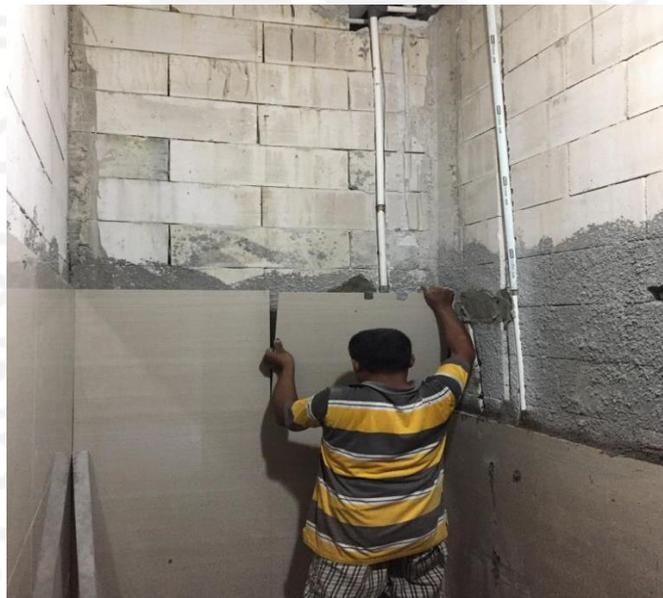
**Gambar 5.3** Pemasangan keramik dinding
