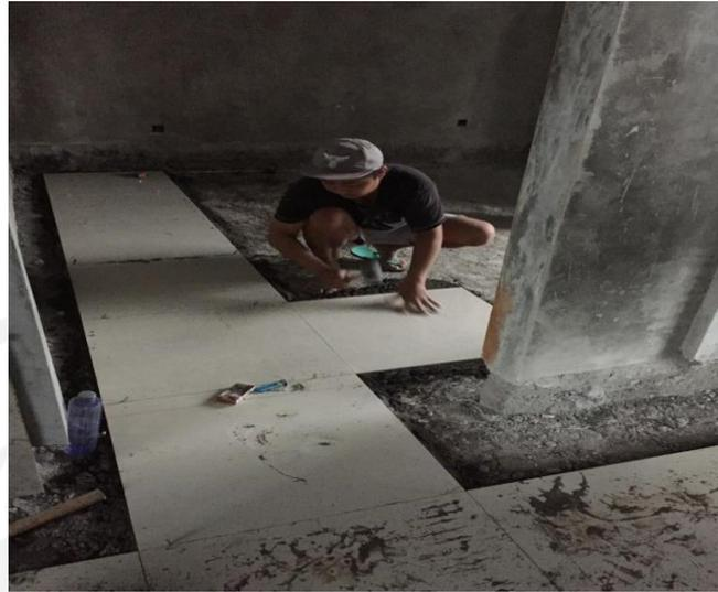
**Gambar 5.4** Pemasangan Keramik lantai
