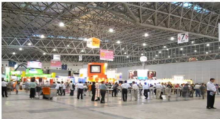
Pada bangunan Nippon Convention Center di samping merupakan salah satu bangunan convention yang menggunakan space frame sebagai struktur atap. Pemilihan penggunaan truss space frame pada atap ini memungkinkan bentuk atap yang beragam pada bangunan yang memiliki bentang lebar yang cukup besar
