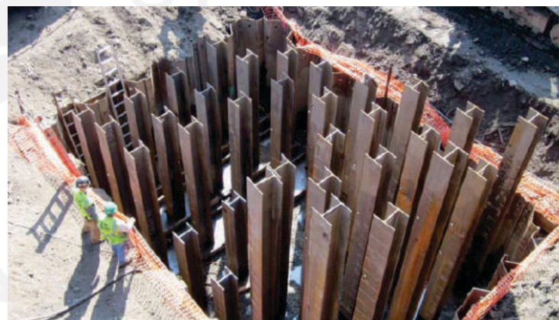
Gambar 2.42 Pondasi Tiang Pancang Baja Sumber: google image
