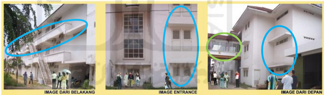
Gambar 2.2 44. Fasad tampak bangunan gedung D Galeri Nasional Indonesia
