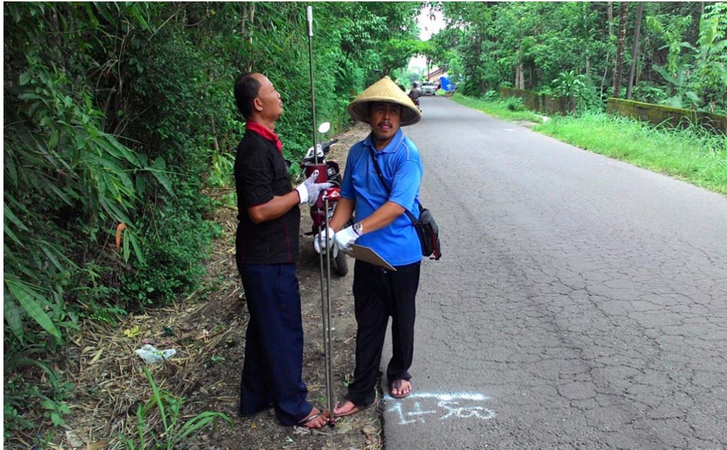
Gambar 1.1 Pemeriksaan DCP di lapangan.
