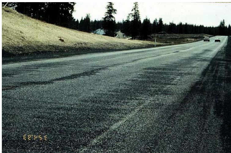
Gambar 3.10 Pelepasan Butiran ( Ravelling )
