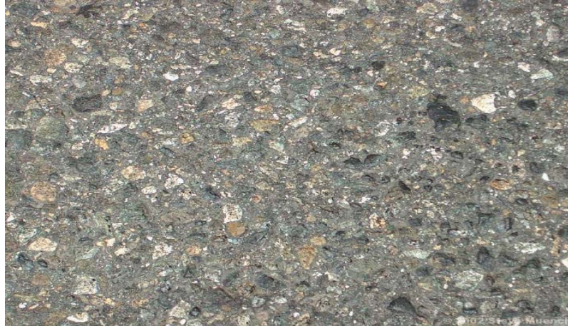
Gambar 3.12 Pengausan jalan dari tampak dekat ( Polished aggregate )
