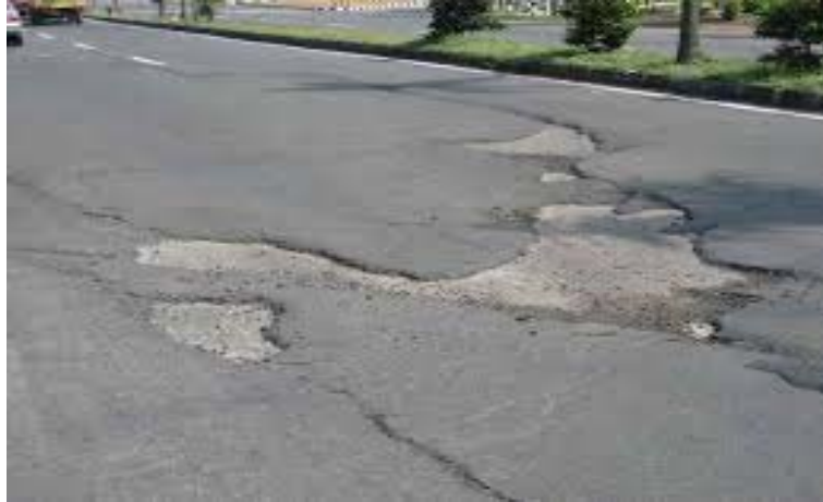
Gambar 3.11 Pengelupasan Lapisan Permukaan ( Stripping )
