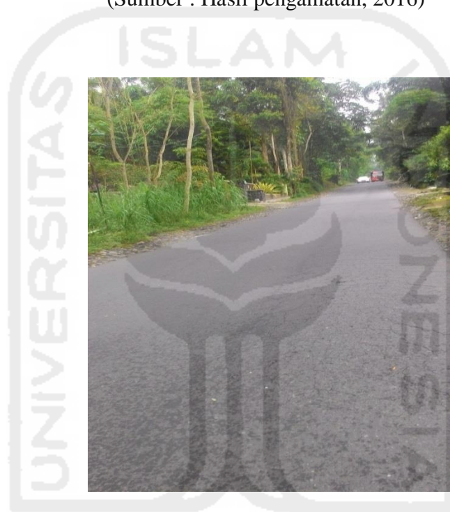
Gambar 5.2 Kondisi Jalan Rating Fair (Sumber : Hasil pengamatan, 2016)
