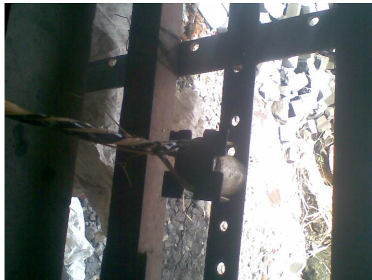
Gambar 4.15 Pembuatan Tulangan Bambu Apus Pilin
