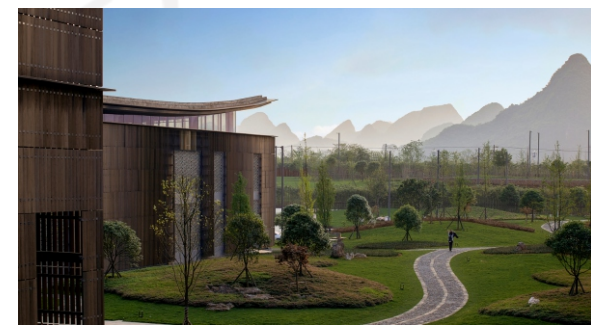
Gambar 2.19 Contoh penerapan eco design pada bangunan Sumber : https://www.archdaily.com/ , 2020
