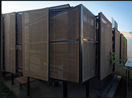
Gambar 3.15 Bambu sebagai selubung bangunan Sumber : https://www.constructionplusasia.com , 2020
