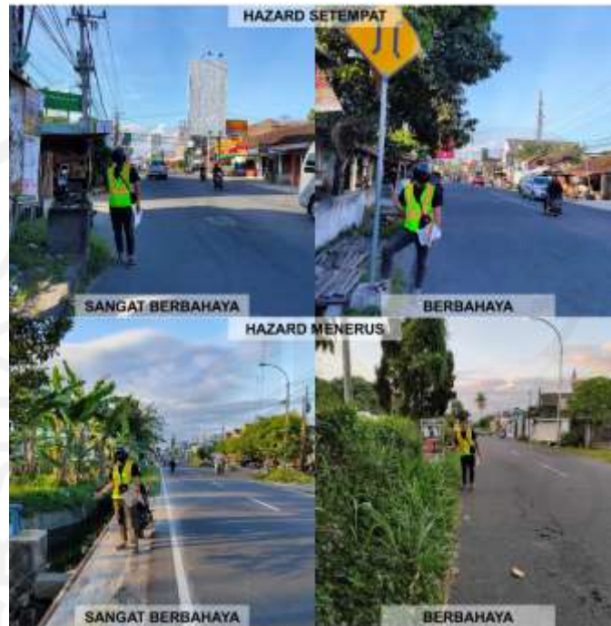
Gambar 5.3 Penilaian Tingkat Bahaya Hazard Sisi Jalan
