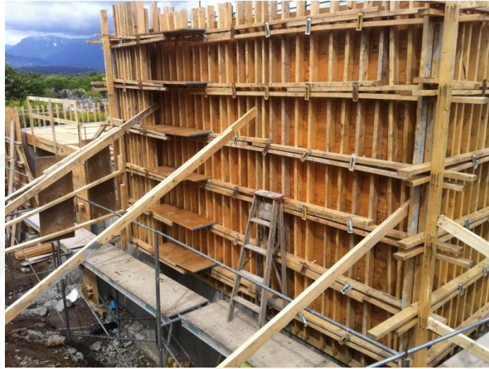
Gambar 3. 1 Bekisting Konvensional
