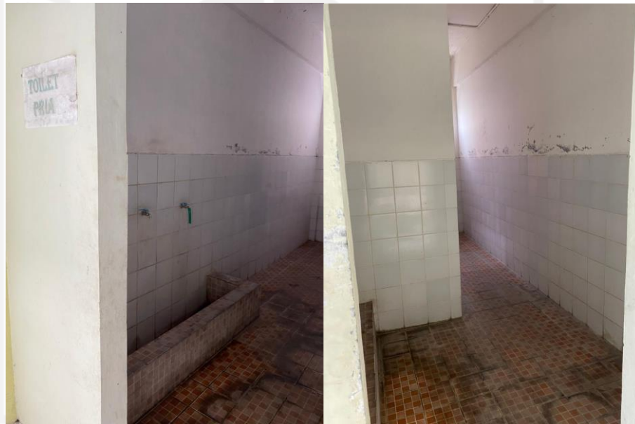
Gambar 5.2 Dinding Keramik Pada Kamar Mandi Gedung Rusunawa
