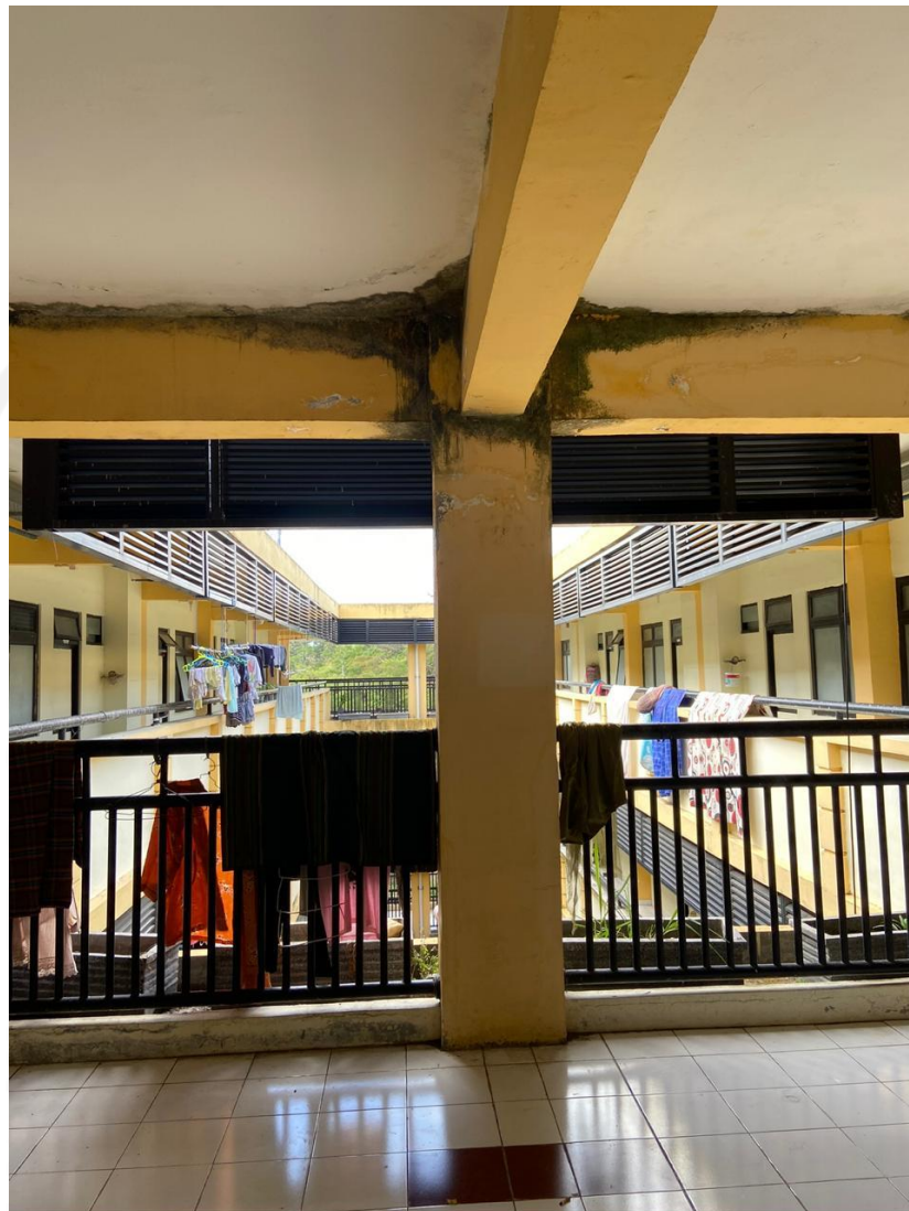
Gambar 5.9 Kolom yang Rembes
