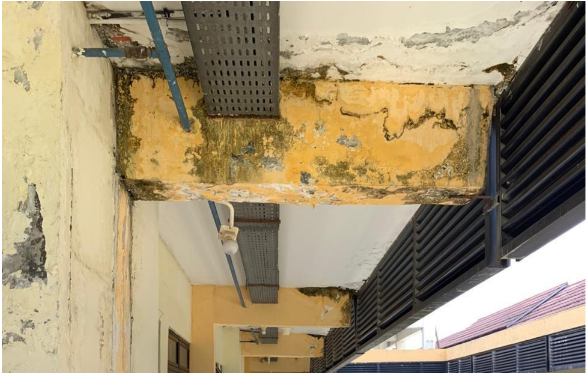
Gambar 5.8 Balok yang Berlumut
