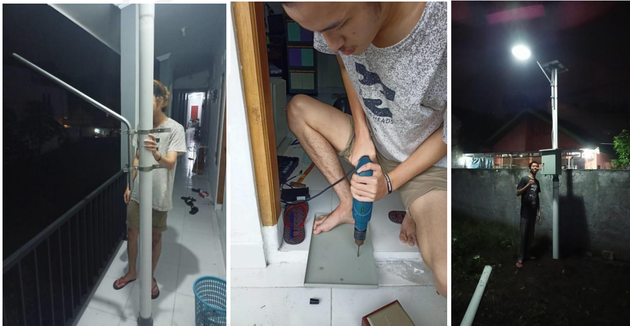
Gambar 5.1.1 Proses pembuatan tiang
