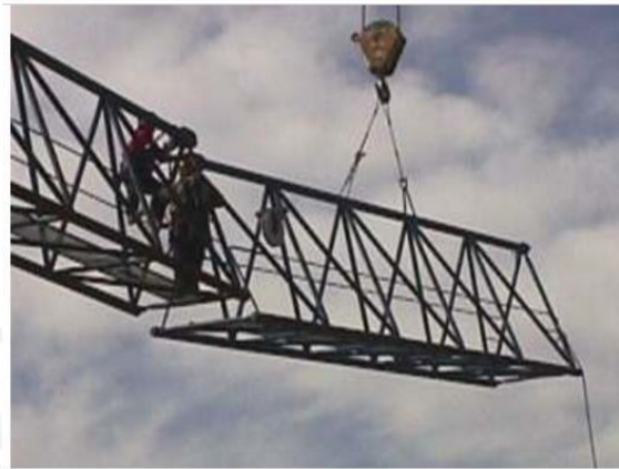
Gambar 3.14 Perakitan Jib dan Machinery Arm
