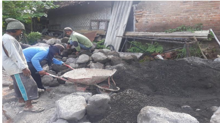
Gambar 5.6 Tenaga Kerja Saat Memindahkan Material
