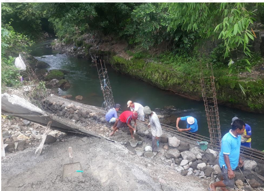
Gambar L-1. 4 Gambar Pemasangan Batu Kali
