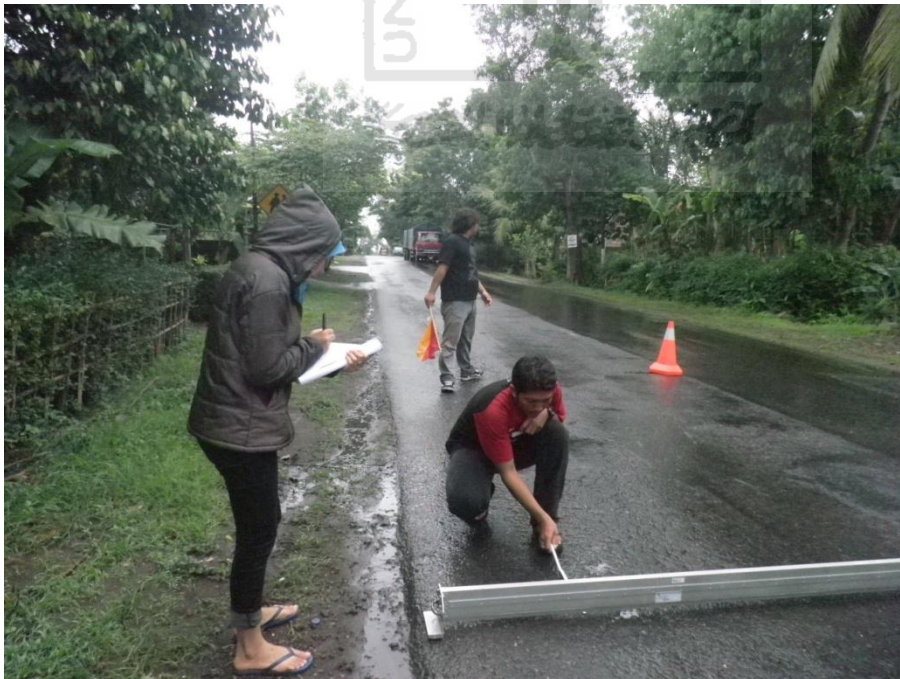
Gambar 8. Pengambilan Data PSI dengan Alat Straight Edge .
