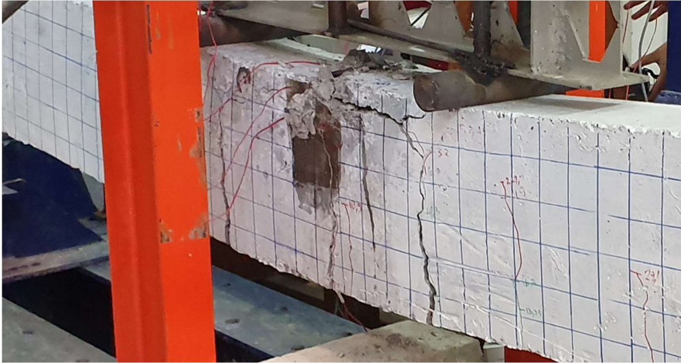
Gambar 5. 33 Kondisi Balok 4 Setelah Uji Lentur
