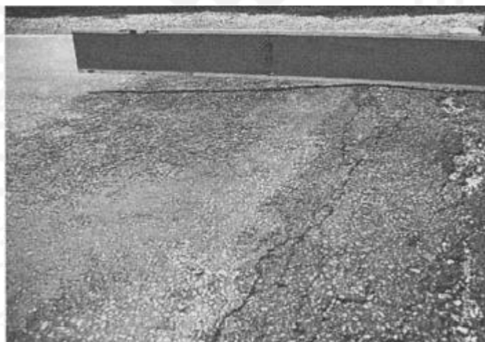
Gambar 3.6 Jembul dan Penurunan ( Bumps and Sags )
