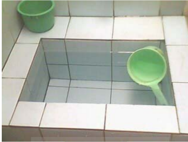
Gambar toilet pasar
