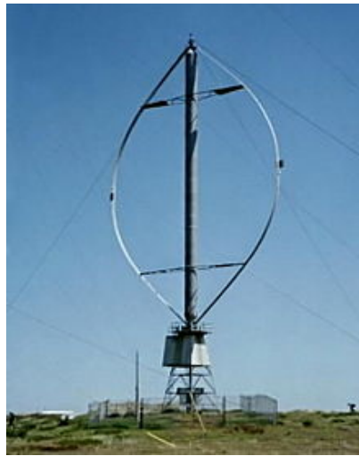
gambar 2.12 Turbin angin Darrieus 30 m di Kepulauan Magdalen
