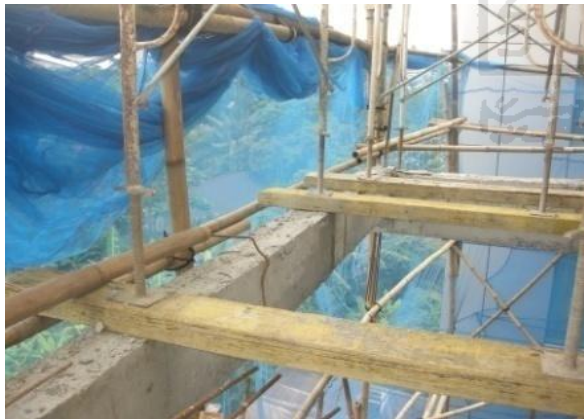
Gambar 5.8 Penggunaan scaffolding yang aman (Foto 7)
