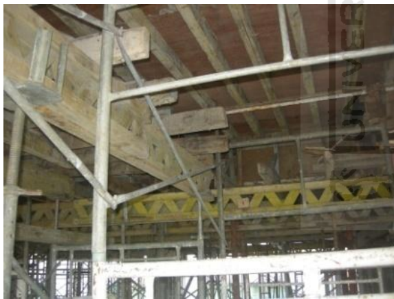
Gambar 5.28 Penggunaan scaffolding yang aman (Foto 27)
