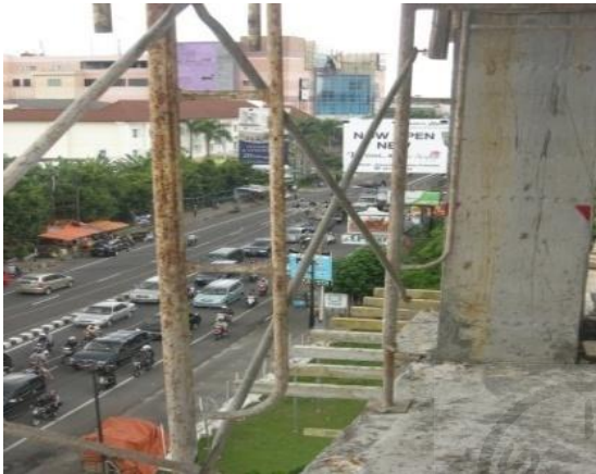
Gambar 5.7 Penggunaan scaffolding yang aman (Foto 6)
