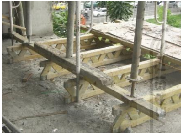
Gambar 5.2 Penggunaan scaffolding yang aman ( Foto 1)
