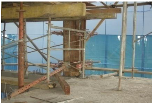
Gambar 5.13 Penggunaan scaffolding yang aman (Foto 12)
