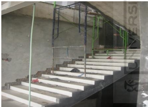
Gambar 5.10 Penggunaan scaffolding yang aman (Foto 9)
