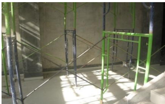
Gambar 5.6 Penggunaan scaffolding yang aman (Foto 5)
