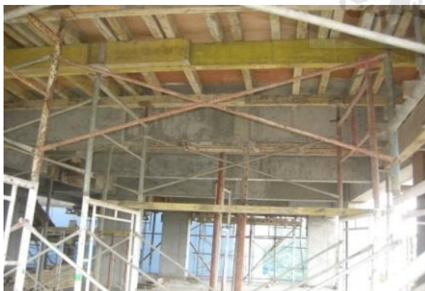
Gambar 5.15 Penggunaan scaffolding yang aman (Foto 14)
