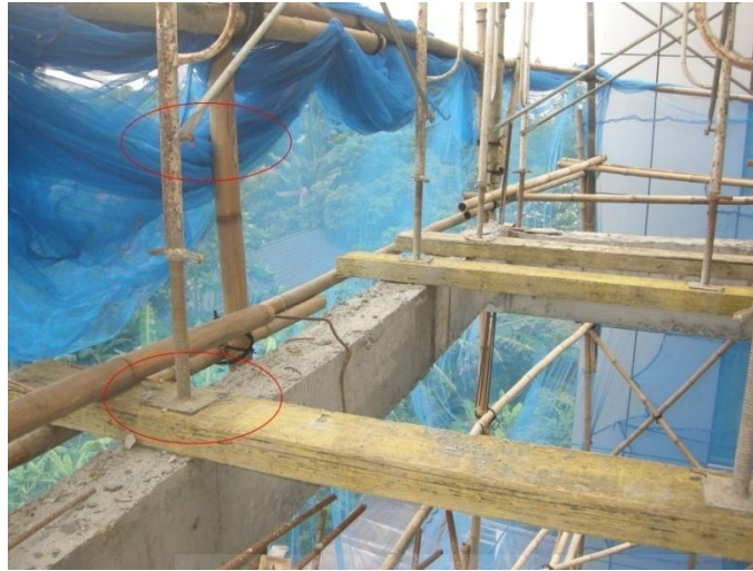
Gambar 5.1 Penilaian bagian dasar dan pengunci brace
