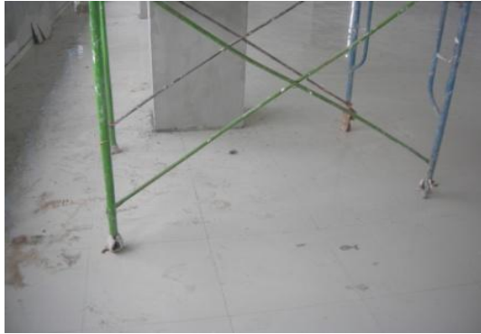
Gambar 5.4 Penggunaan scaffolding yang aman (Foto 3)
