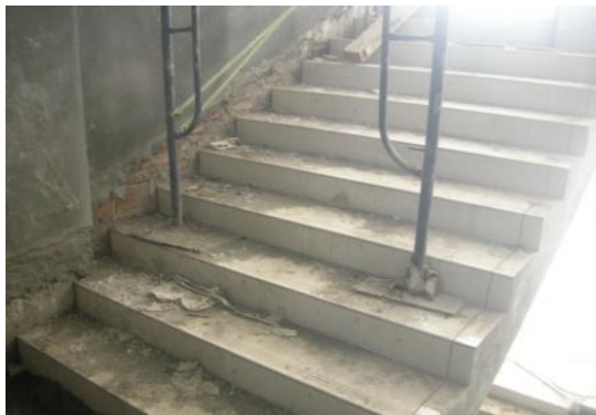
Gambar 5.3 Penggunaan scaffolding yang aman ( Foto 2 )
