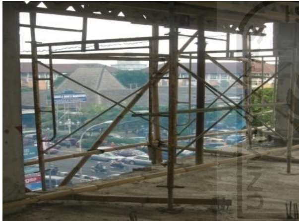
Gambar 5.12 Penggunaan scaffolding yang aman (Foto 11)
