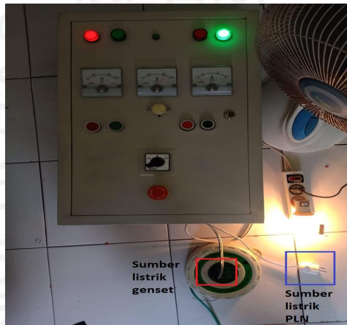
Gambar 5.5 Pengujian switching otomatis ketika listrik PLN diputus
