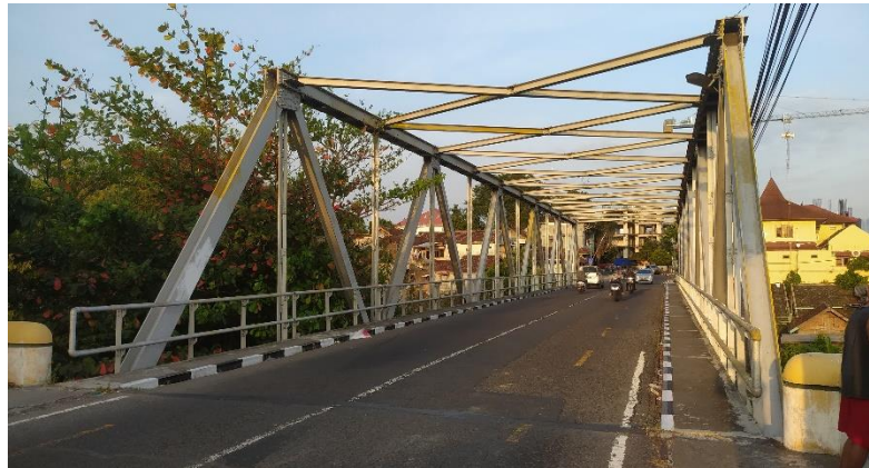
Gambar 4.3 Struktur Eksisting Jembatan Sardjito 1
