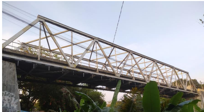
Gambar 4.4 Struktur Eksisting Jembatan Sardjito 1
