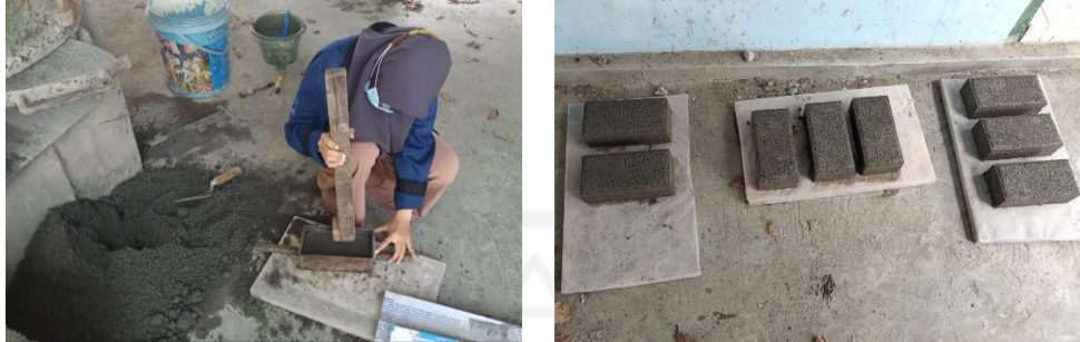
Gambar 3.4 Proses Pencetakan
