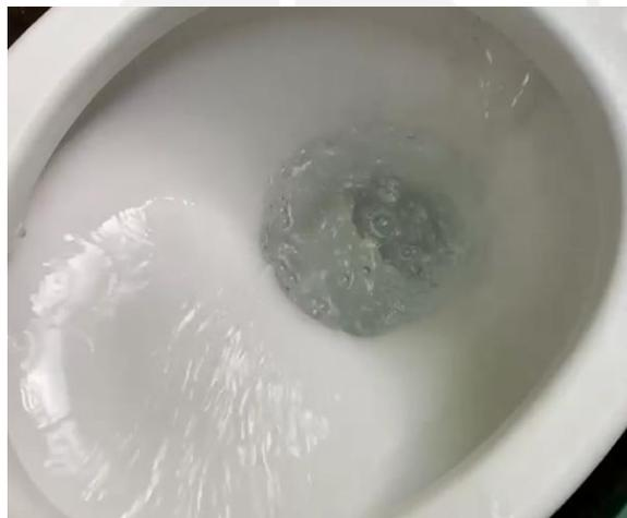
Gambar 4-20 Pembilasan Permukaan Wadah Kloset dengan Debit 0,3 L/detik
