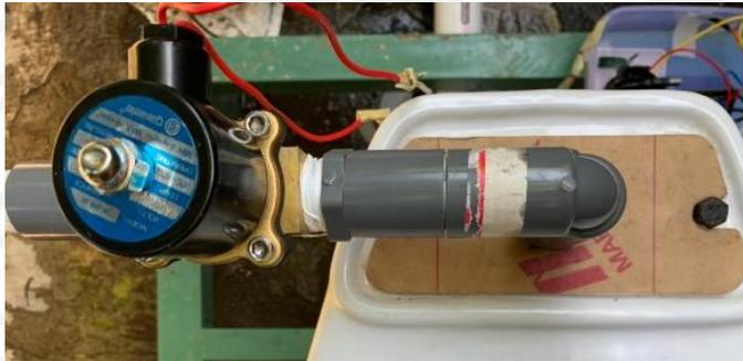
Gambar 4-16 *Solenoid Valve* sebagai Pembilas Otomatis
