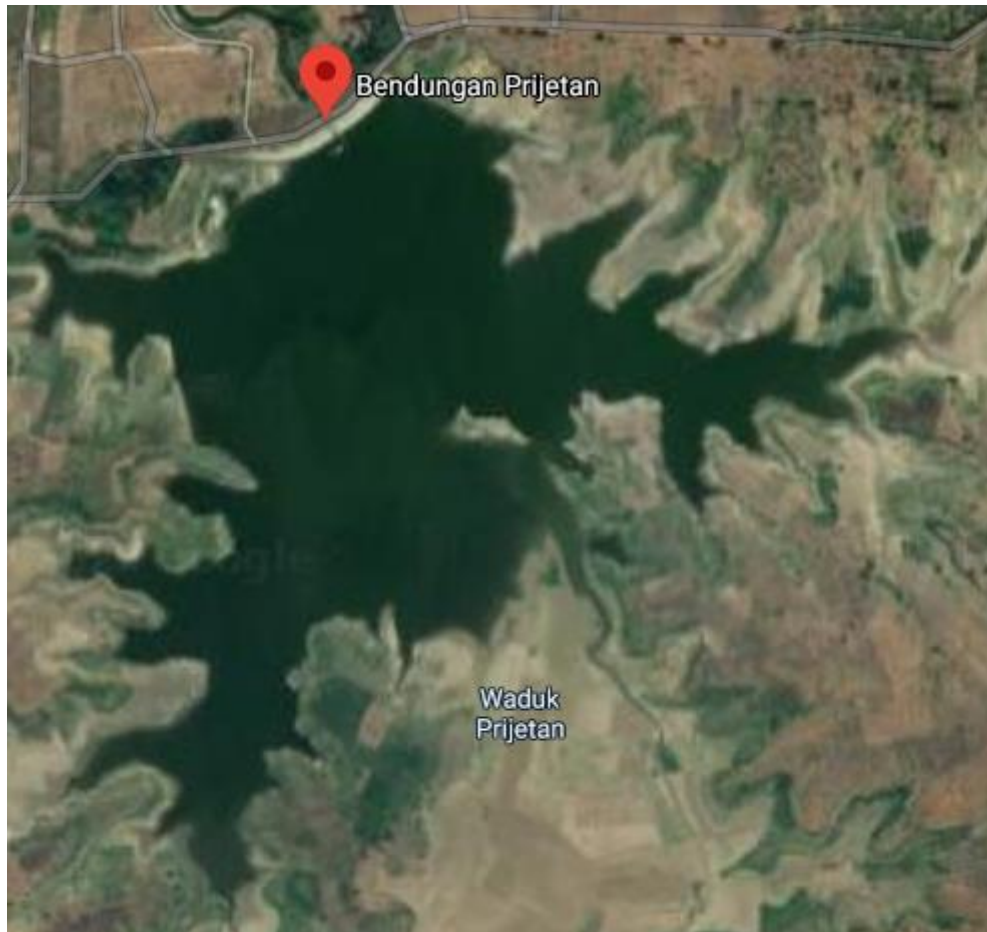
Gambar 1. 1 Tampak Atas Bendungan Prijetan
