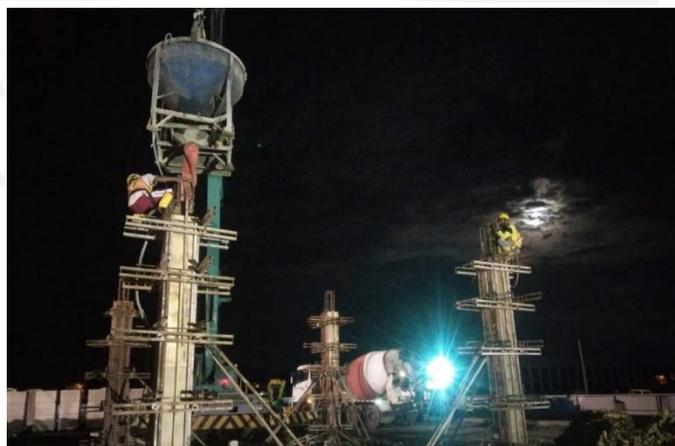
**Gambar 5.9 Proses Pengecoran Kolom**
