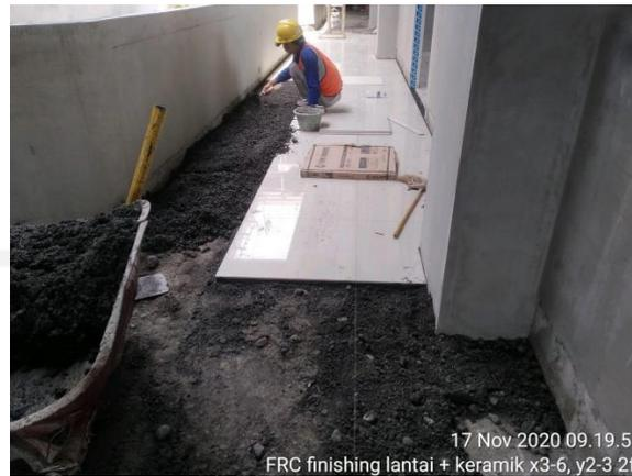
**Gambar 5.23 Proses Pemasangan Keramik**
