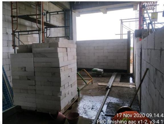
**Gambar 5.18 Proses Pemasangan Bata Ringan**
