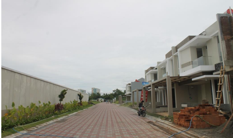
Gambar 5.7 Kondisi Jalan Sekitar Proyek
