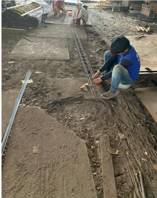
Gambar 4.6 Pembuatan kerangka besi (bekisting)
