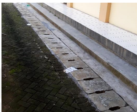
Gambar 5.21 Drainase Saluran Air Bekas
