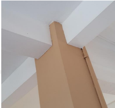
Gambar 5.4 Sambungan Balok dengan Kolom
