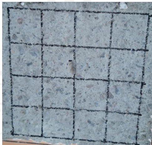
Gambar 5.33 Daerah Pengujian Hammer Test
