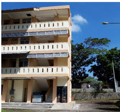
Gambar 5.5 Bangunan Tidak Mengalami Miring
