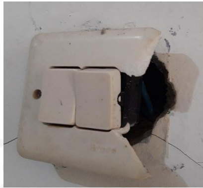
Gambar 5.25 Retak pada Saklar Ganda
