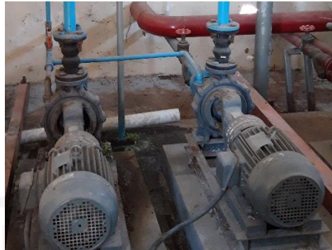
Gambar 5.24 Pompa Air
