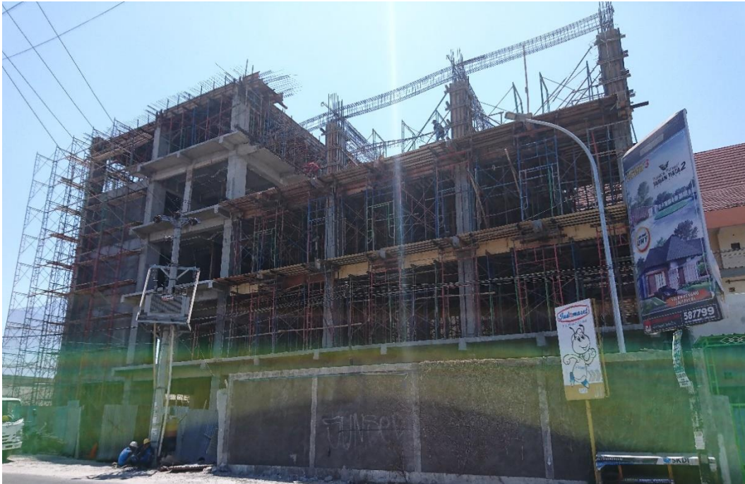
Lampiran L-2. 8 Pembangunan Gedung Fakultas Teknik UPY
