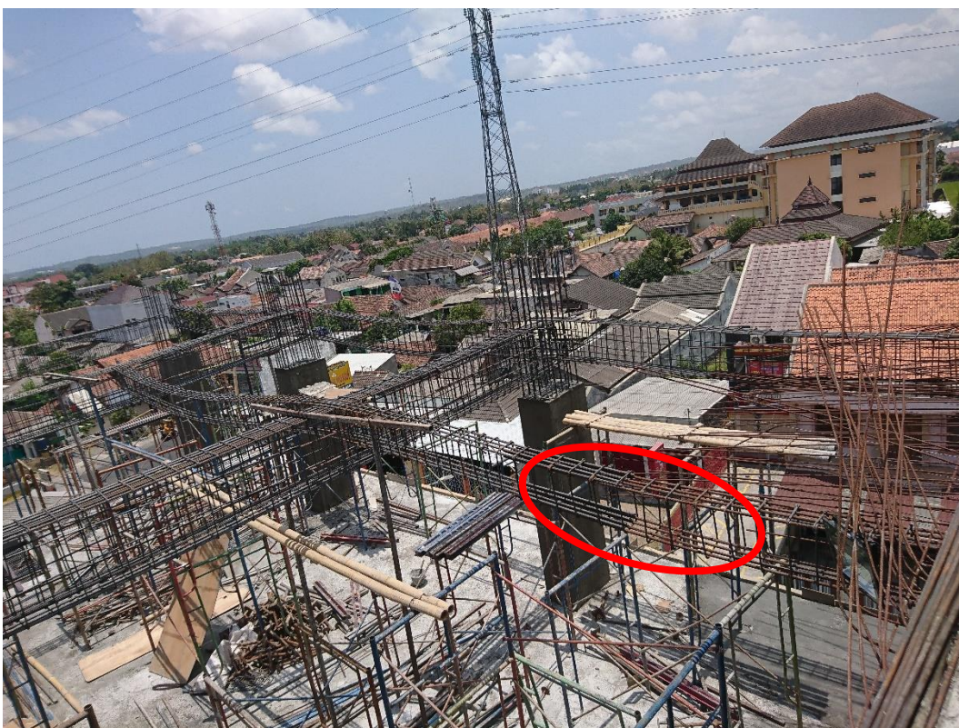
Lampiran L-2. 11 Pemasangan Tulangan Menerus
