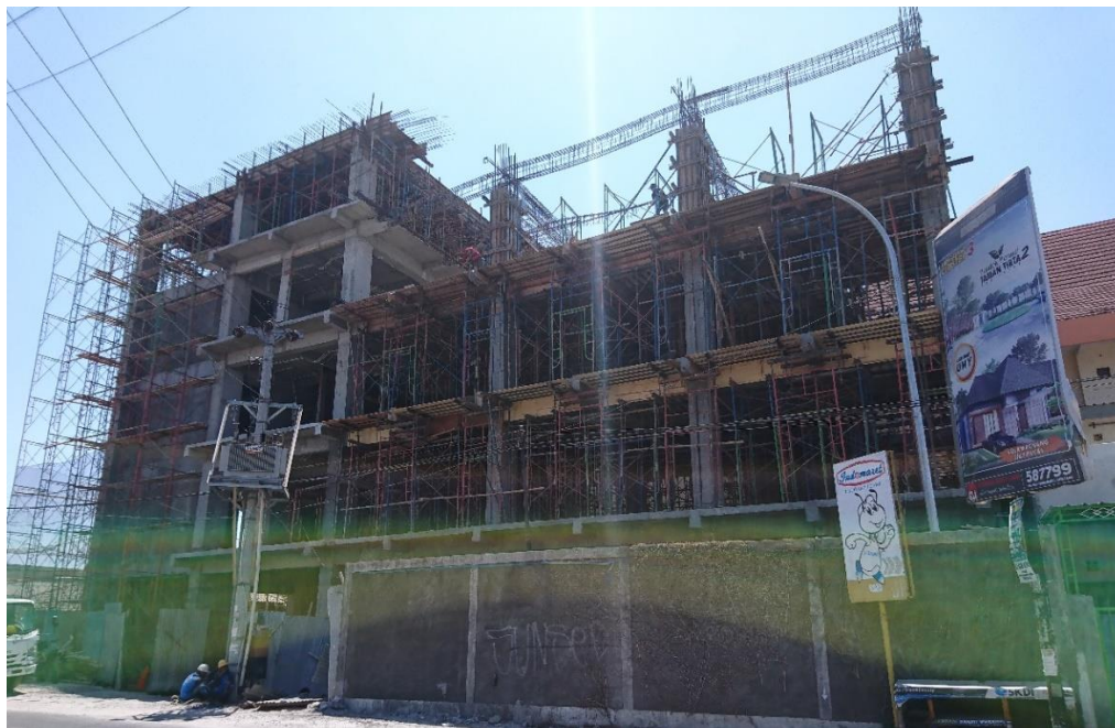
Gambar 5. 1 Pembangunan Gedung Fakultas Teknik UPY
