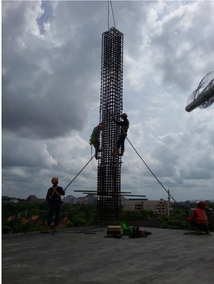
Gambar 7. 10 Tulangan kolom satu set
