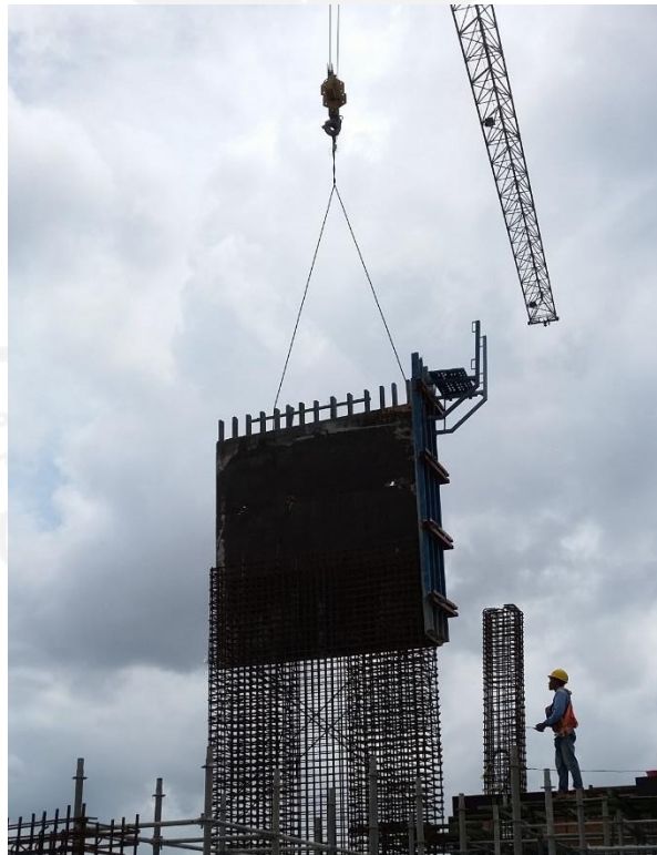
Gambar 7. 9 Pengangkatan bekisting shearwall
