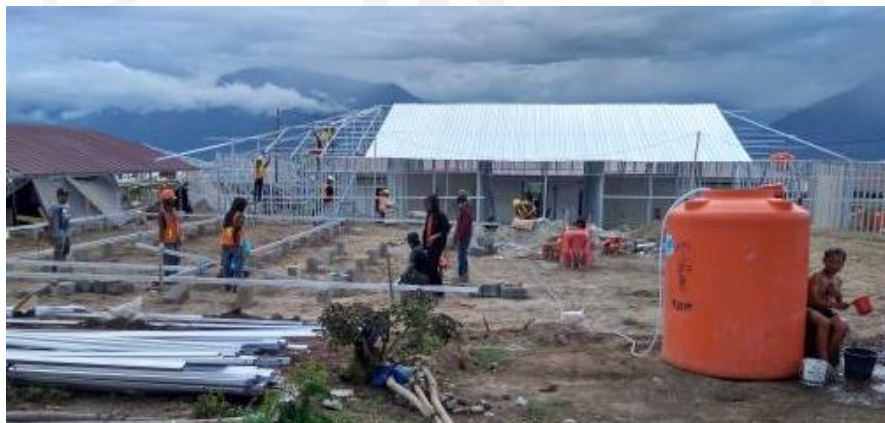
Gambar 38. Proses pelaksanaan pembangunan unit huntara (1) Sumber : Penulis, 2018
