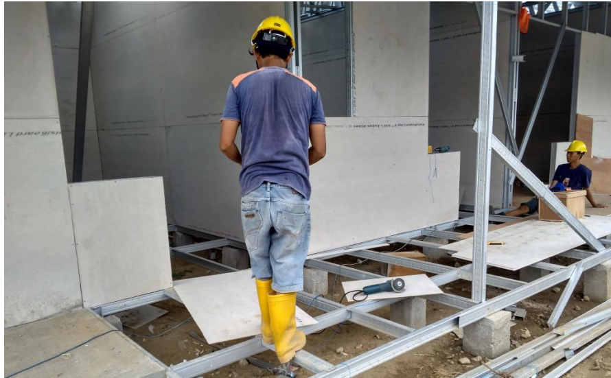
Gambar 39. Proses pelaksanaan pembangunan unit huntara (2) Sumber : Penulis, 2018
