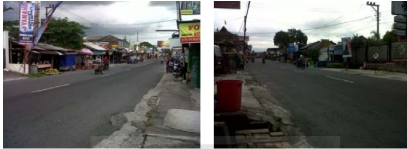
Gambar 3.14 : Kondisi Jalan Kaliurang Km.14
