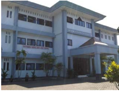
Gambar 3.7 : Bangunan AKPER Panti Rapih Sebagai bangunan kegiatan pendidikan Sumber : Survey, 4 Juli 2011
