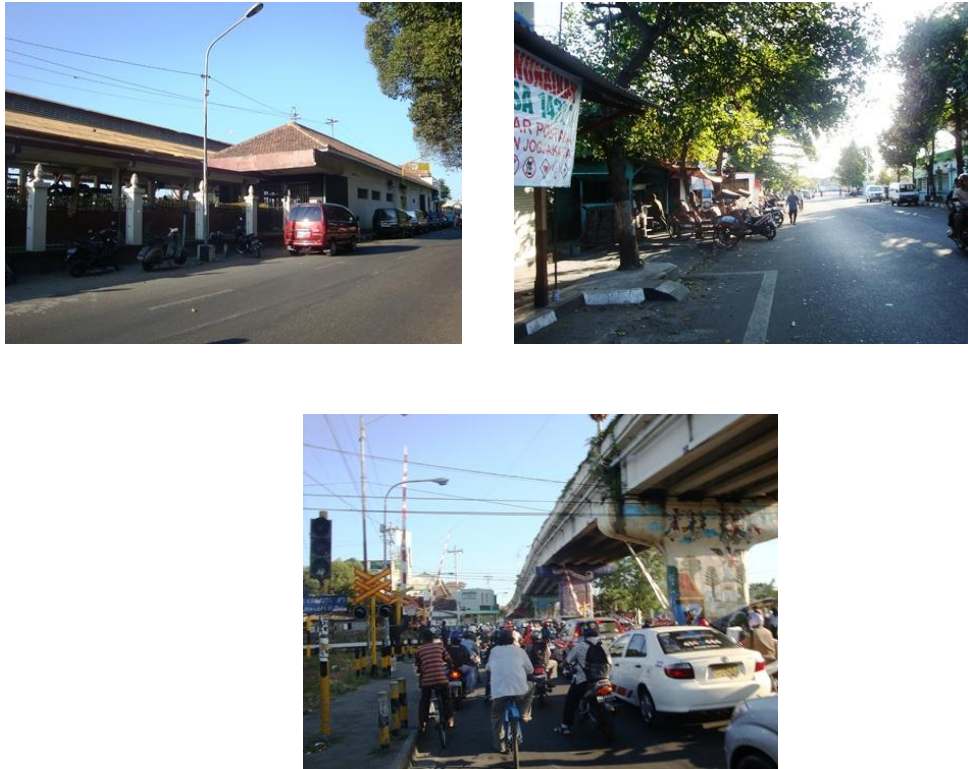
Gambar1.1 Kondisi kawasan Stasiun Lempuyangan
