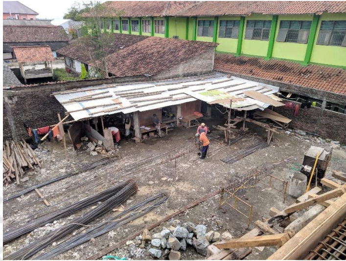
Gambar L-2. 5 Penempatan Fasilitas Fabrikasi Besi dan Fasilitas Lainnya
