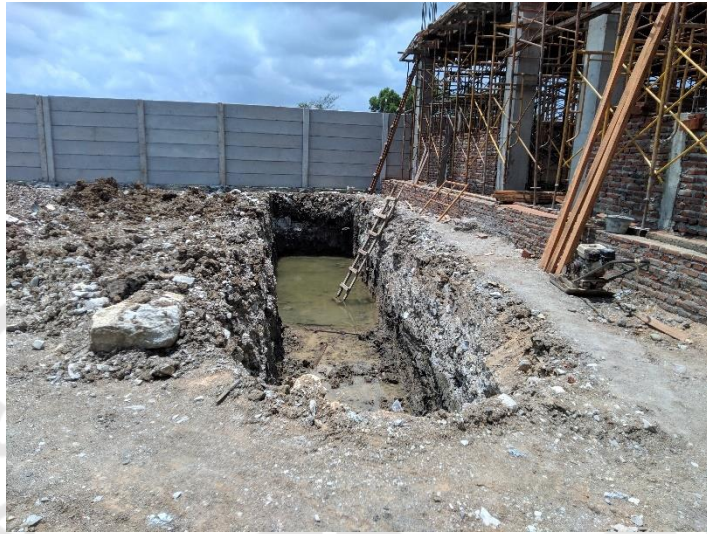
Gambar L-2. 3 Lubang untuk Pekerjaan Groundtank
