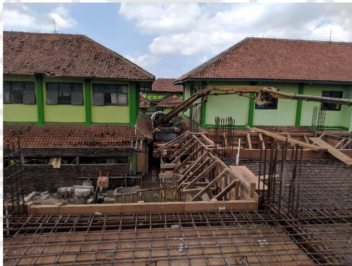
Gambar L-2. 10 Proses Pengecoran dengan Concrete Pump
