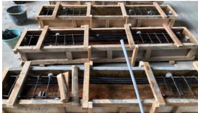
GAMBAR 15 BEKISTING YANG SUDAH TERPASANG TULANGAN
