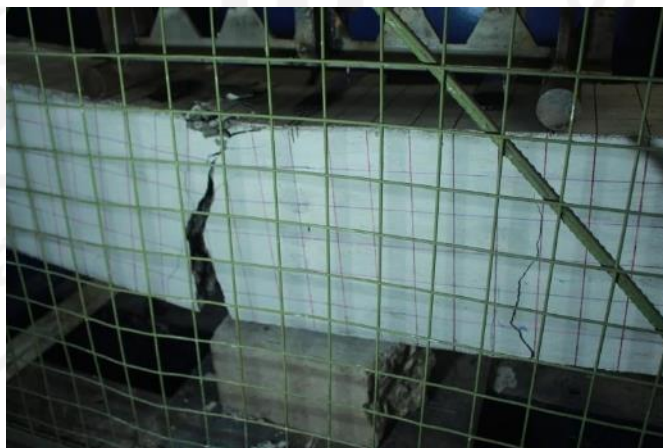
GAMBAR 37 SAMPEL KERUSAKAN BALOK VARIASI II
