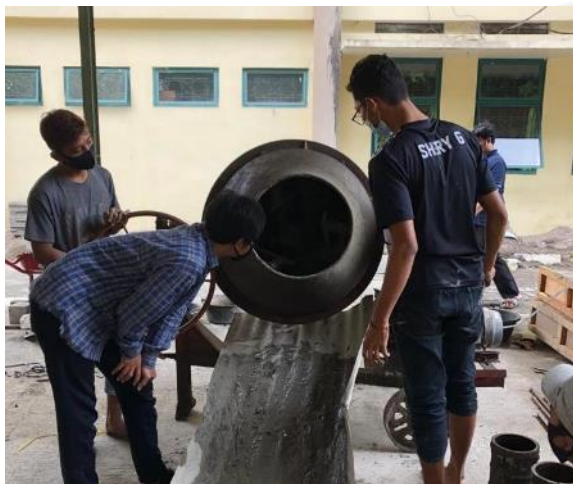
GAMBAR 5 PELAKSANAAN PENGADUKAN CAMPURAN BETON
