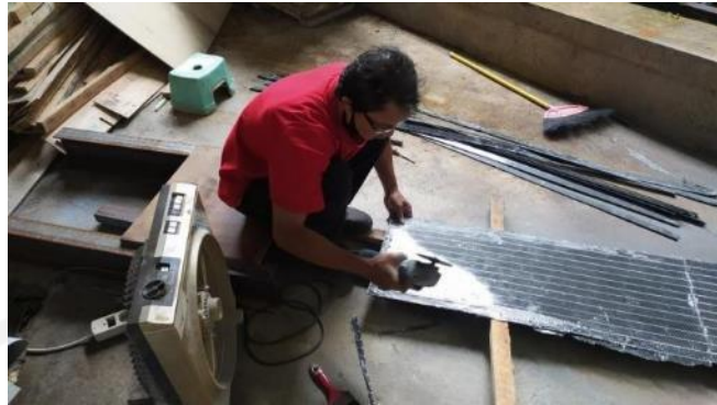
GAMBAR 10 PEMOTONGAN CFRP
