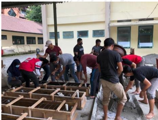
GAMBAR 19 PROSES PENCETAKAN BALOK BETON
