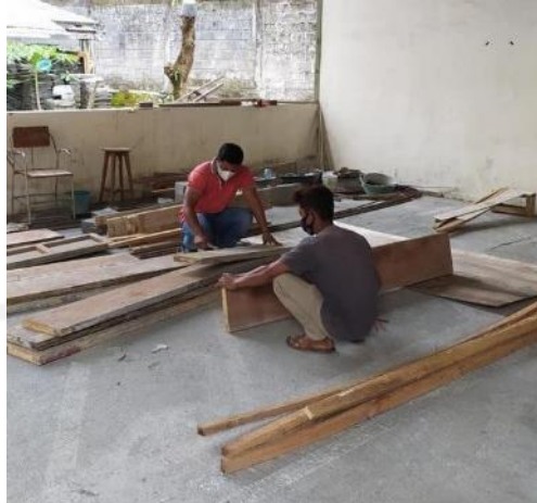
GAMBAR 14 PEMBUATAN BEKISTING BALOK
