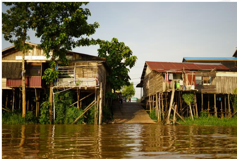
Gambar 1.3 Bangunan area depan pasar yang langsung berada di atas sungai
