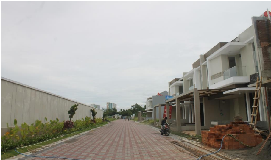
Gambar 5.7 Kondisi Jalan Sekitar Proyek
