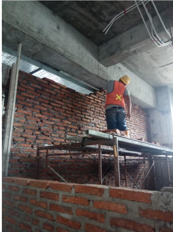
Gambar Lambran 4. 2 Pekerjaan Pasangan Dinding Bata Merah
