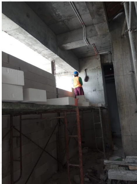
Gambar Lampran 4. 4 Pekerjaan Pasangan Dinding Bata Ringan
