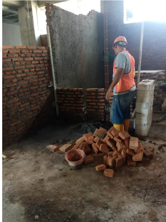
Gambar Lampran 4. 1 Pekerjaan Pasangan Dinding Bata Merah
