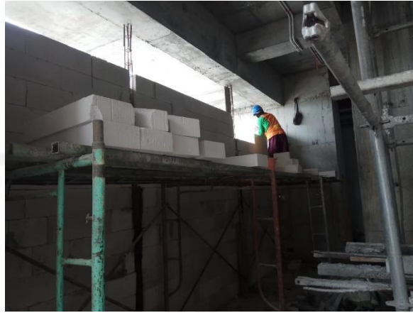
Gambar Lampran 4. 3 Pekerjaan Pasangan Dinding Bata Ringan
