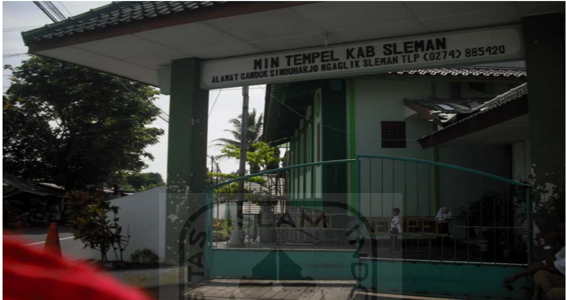
Gambar 3. Observasi kantin dan Kondisi Gedung sekolah 1
