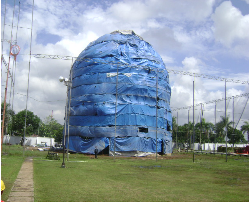
Tangki Timbun Kapasitas 2500MT (dalam tahap pembangunan)
