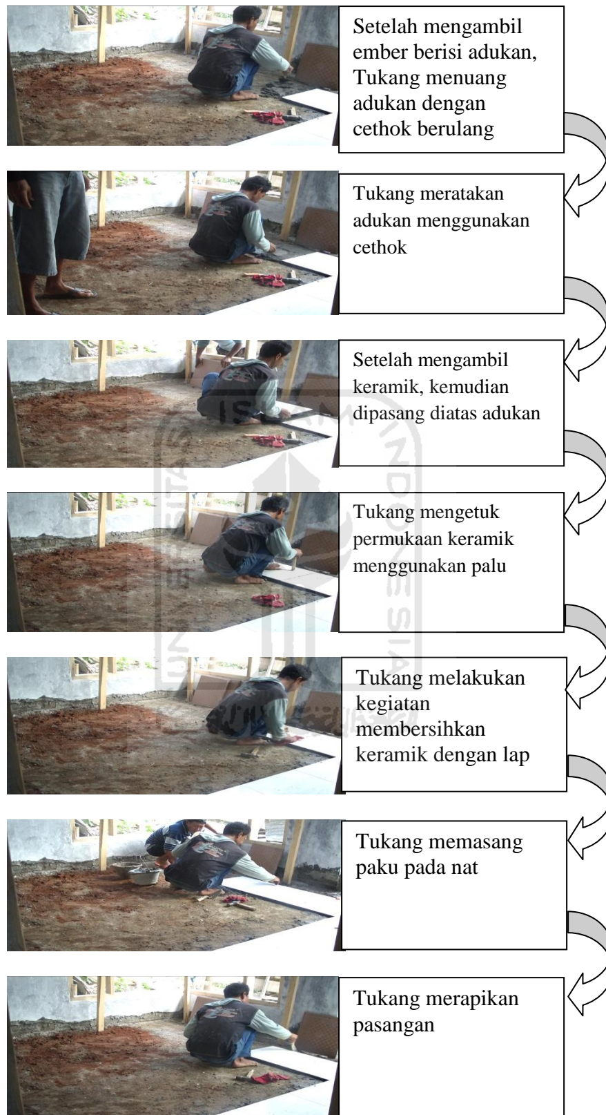
Gambar 5.11 Pemasangan Keramik dengan Metode Kerja 4 (empat)
