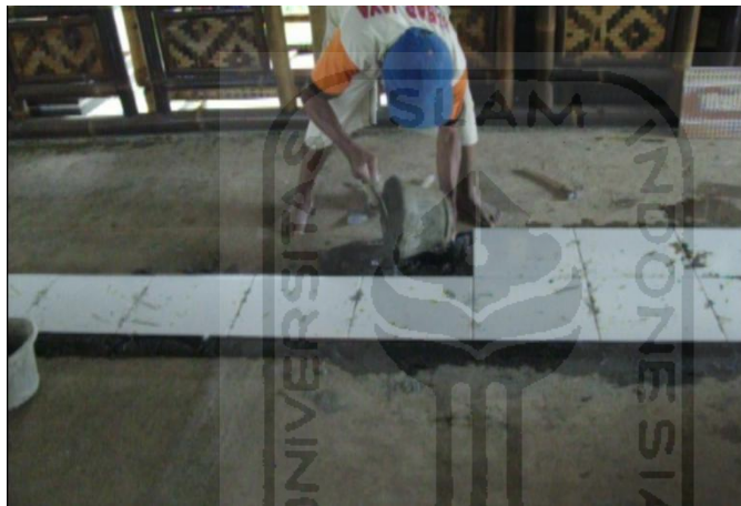
Gambar 5.19 Tukang tidak melakukan perapihan dan mengelap keramik
