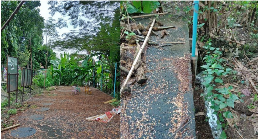
Gambar 4.21 Observasi IPAL Sengkan Sehat (kiri: foto IPAL; kanan: foto effluent dari IPAL)
