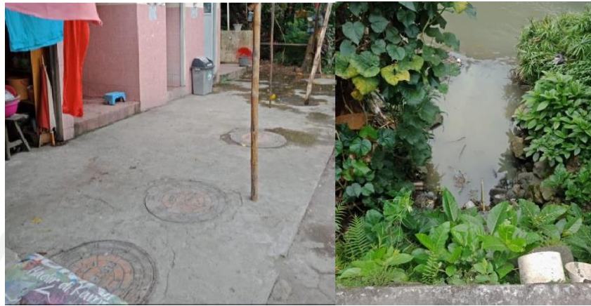
Gambar 4.22 Observasi IPAL Gawe Merem (kiri: foto IPAL; kanan: foto effluent dari IPAL)
