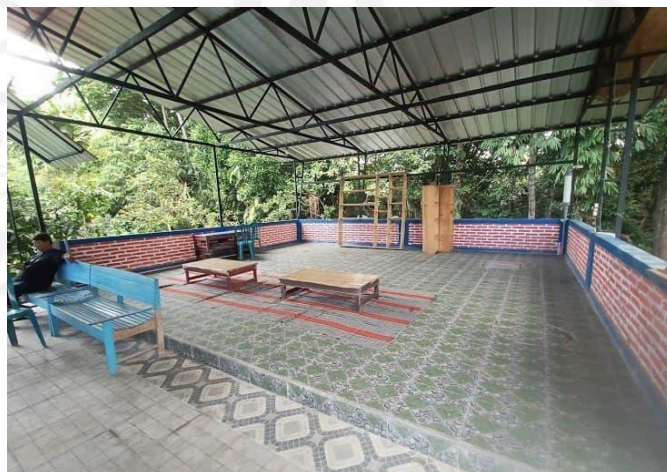
Gambar 4.21 IPAL Komunal Ngudi Mulyo (Sumber: Dokumentasi Pribadi, 2021)
